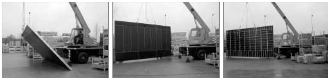
Przykłady przemieszczenia płyt szalunkowych za pomocą dźwigu
